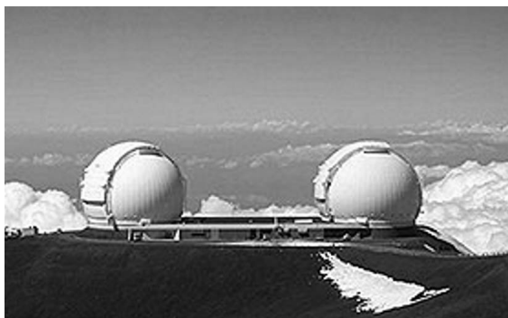
Obr. 2. Keckovy dalekohledy na Havajských ostrovech. Disponují 10m zrcadly s adaptivní optikou a vysokodisperzním spektrografem HIRES. Společně mohou pracovat jako interferometr se základnou 85 m. (Foto: W. M. Keck Observatory.)
