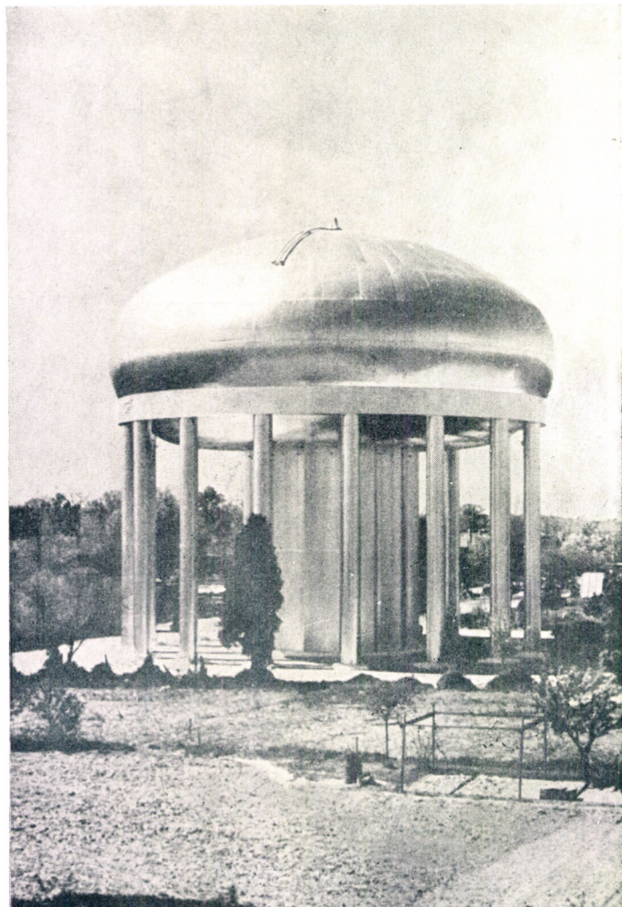
Ocelová nádrž na tekutiny ve tvaru kapky s poledníkem v jediné křivce.
