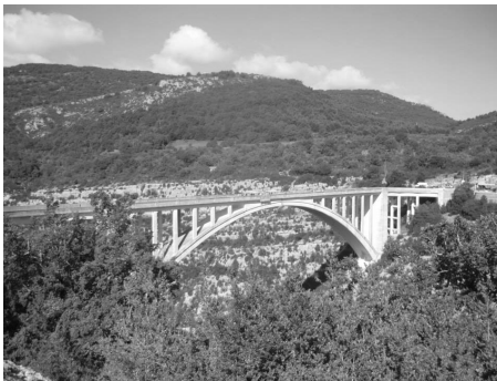
Pont de l'Artuby
