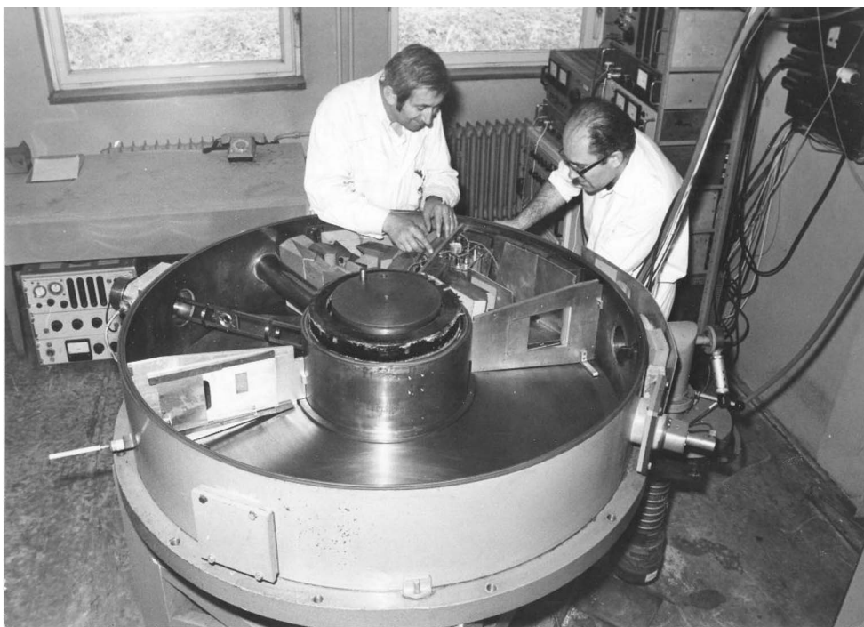
Obr. 2 Magnetický železný spektrometr záření beta s dvojitou fokusací s poloměrem stabilní dráhy 50 cm s veškerým vnitřním i vnějším příslušenstvím.
